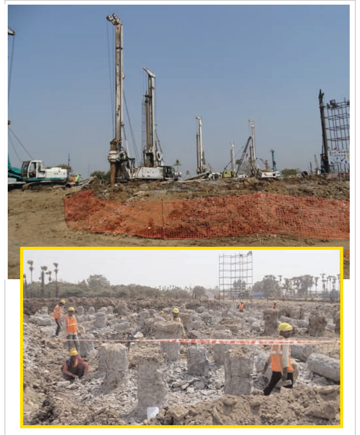
ఏపీ రాష్ట్ర రాజధాని రామమూడిలో వేగవంతంగా జరుగుతున్న ఎమ్మెల్యే, ఎమ్మెస్సీ, (క్రీంద) వి.వి.ఎన్ ఆధికారుల భవన నిర్మాణ పనులు
