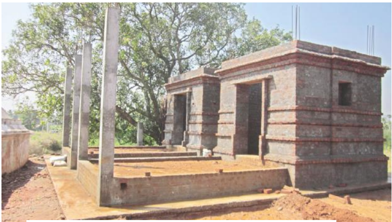
గ్రామంలో నిర్మాణంలో ఉన్న ఆలయం
