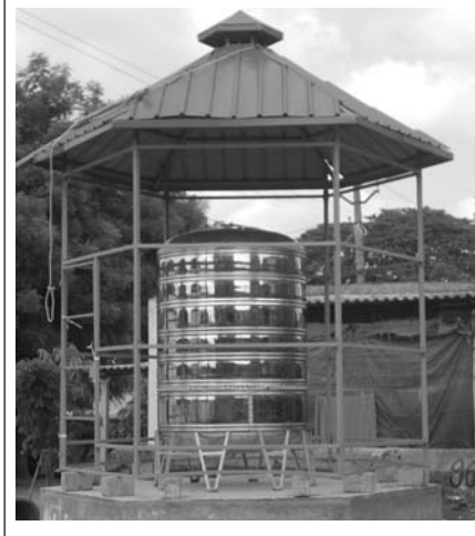
ఎన్టీఆర్ సుజల పథకం కింద రాయపూడి లో నిర్మాణంలో ఉన్న మంచినీటి ట్యాంక్
