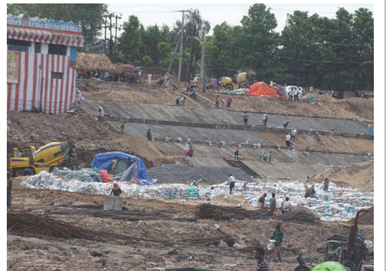
సీతమ్మవారి పాదాల వద్ద నిర్మాణపు పనులు జరుపుకుంటున్న పుష్కరపూట్
